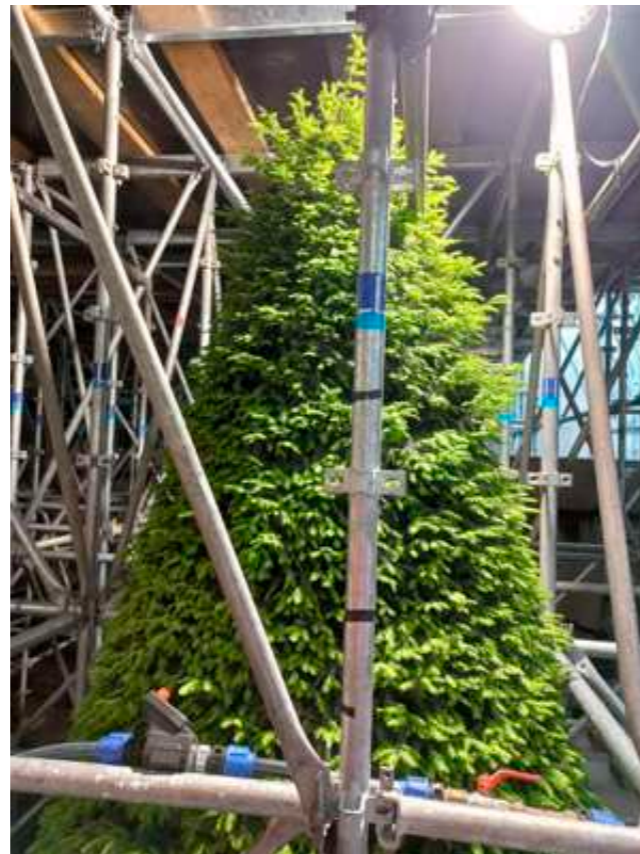
Protection des ifs sur le site du Trocadéro, Mai 2024 Crédit Paris 2024 (JMA)
